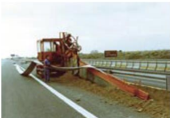
Joonis 33. Liitdrenaaži paigaldamine teepeenra drenaažina
